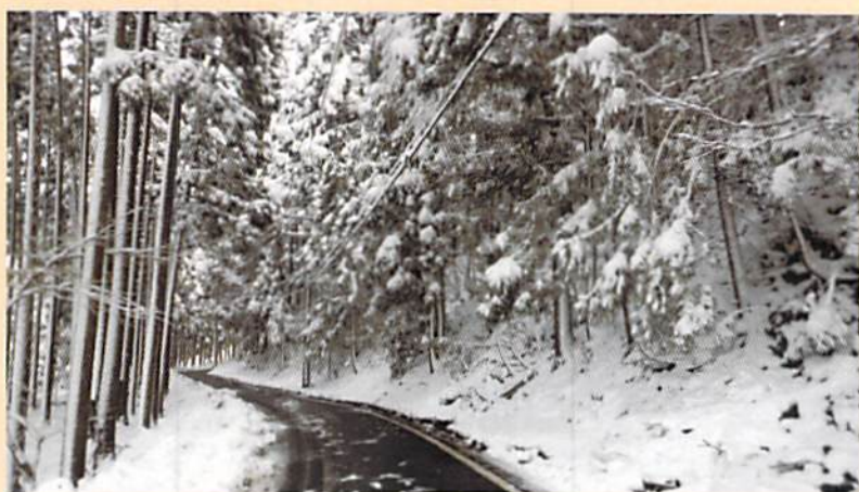
京都府南丹市美山町知井地区佐々里の道路沿い。停電の原因となる雪の重みでたわんだ電線と植林された杉の枝々 (2012年12月22日)
